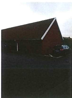
Garage: Uteluft 17,2 grC 88%Rf Gränsen för att mikrobiella skador är 70-75% relativ fuktighet (rf), vilket motsvarar 16-17% fuktkvot (fk).
